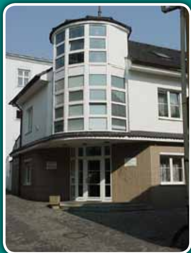
Lekárna Panacea - podrobnosti na str. 27
